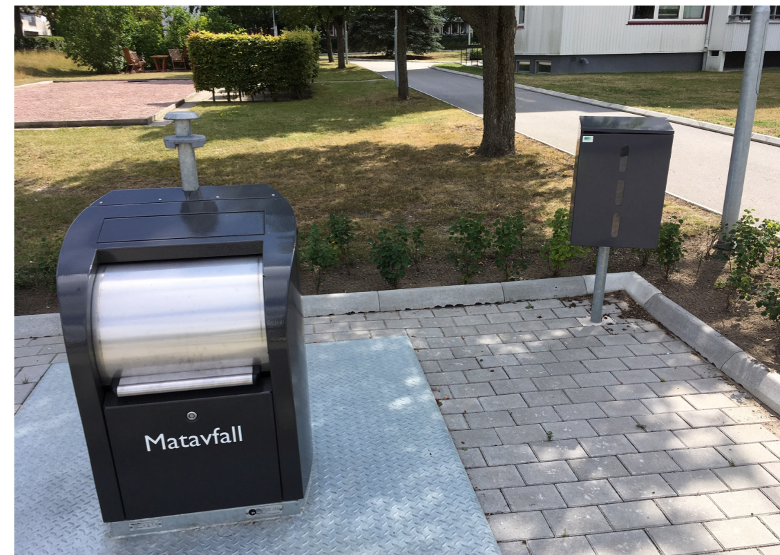
UWS kompletterat med ett skåp för matavfallspåsar
